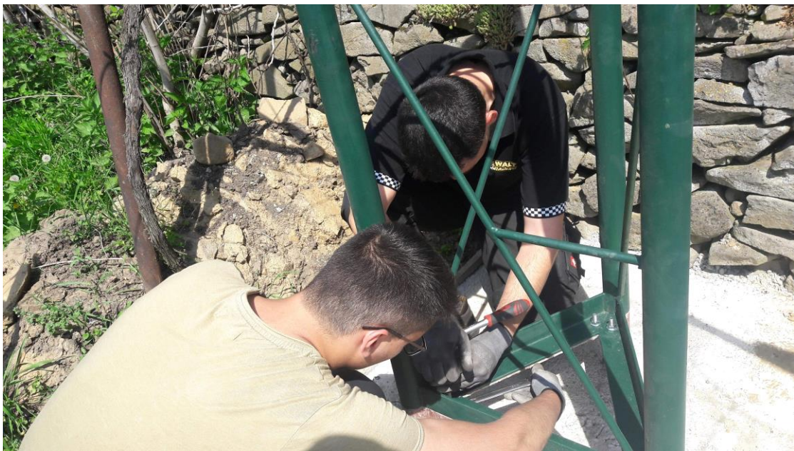
Stawianie konstrukcji pod przyszły montaż anten.
